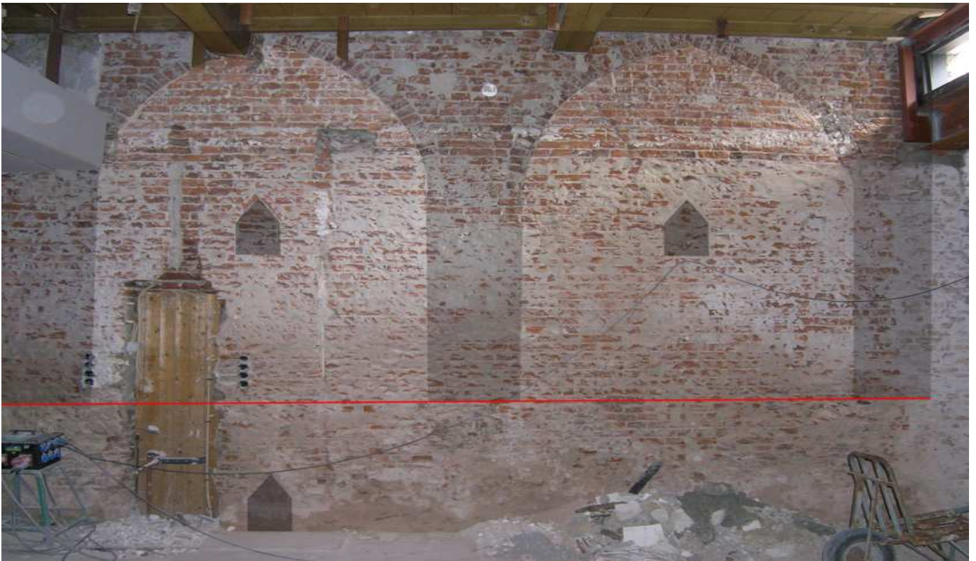
De linker zijmuur van het achterhuis van Orthenstraat 55 met gemarkeerd de spaarbogen en kaarsnissen. De rode lijn is het oorspronkelijke vloerniveau van de kamer boven de kelder. De 17 de -eeuwse balklaag van de verdieping ligt op het oude, 14 de -eeuwse niveau.
